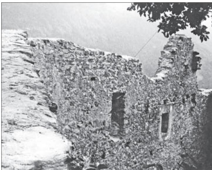
▲ Abb. 49: „Versiegeltes“, gefestigtes Mauerwerk der östlichen Wand (Aufnahme: 1985)
