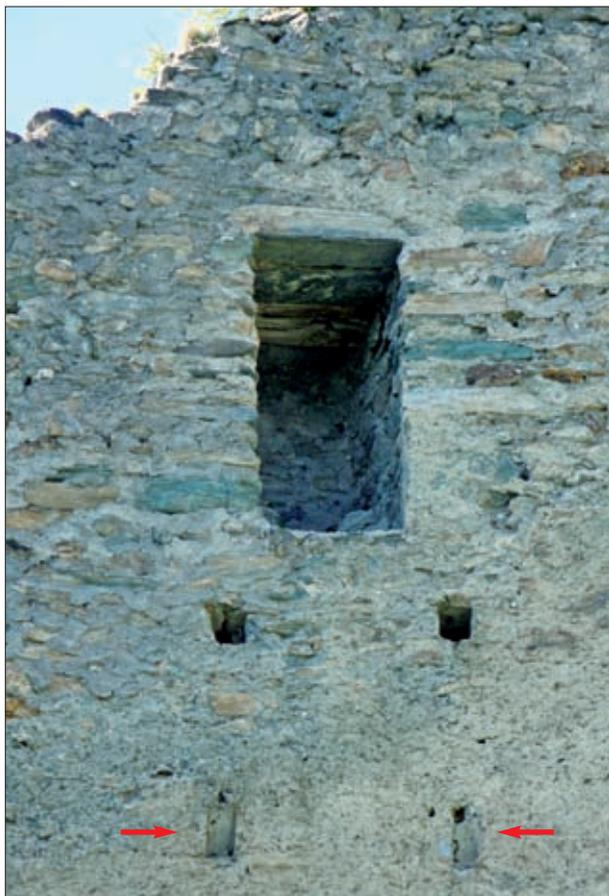
Abb. 34: Widerlager für schräge Pfosten, die den Steg abstützten (mit Pfeilen markiert)
