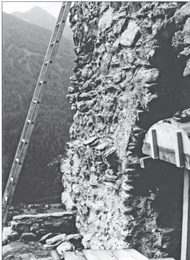
Abb. 48: Schalung zur Wiederherstellung eines Rundbogenfensters
